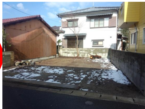
対応後の状況(撤去)
