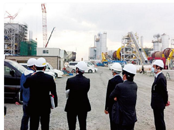
急ピッチで整備が進む焼却炉
